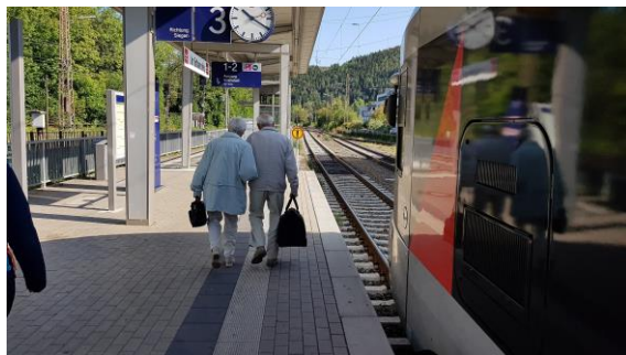
Abbildung 54: Rippenpflaster als Auffinde-/Leitstreifen und Noppenpflaster als Einstiegs- und Aufmerksamkeitsfelder
