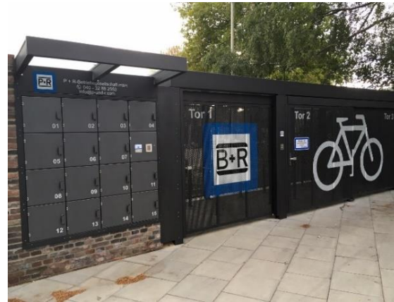
Abbildung 63: Gesicherte Radabstellanlagen mit Schließfächern für Pedelec-Akkus
