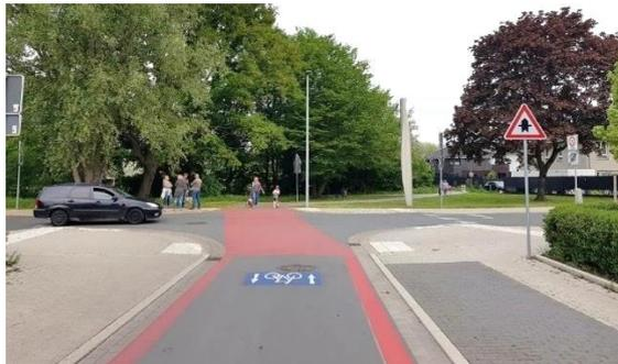
Abbildung 36: Vorgezogene Haltelinie mit aufgeweiteten Radaufstellstreifen
